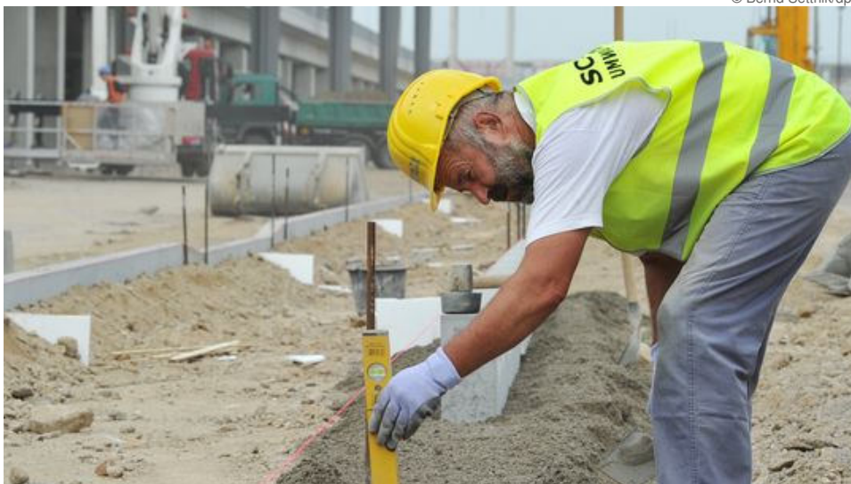
Ein Straßenarbeiter in Berlin: Die Wirtschaft wächst wieder, aber es setzt ein Umdenken ein
